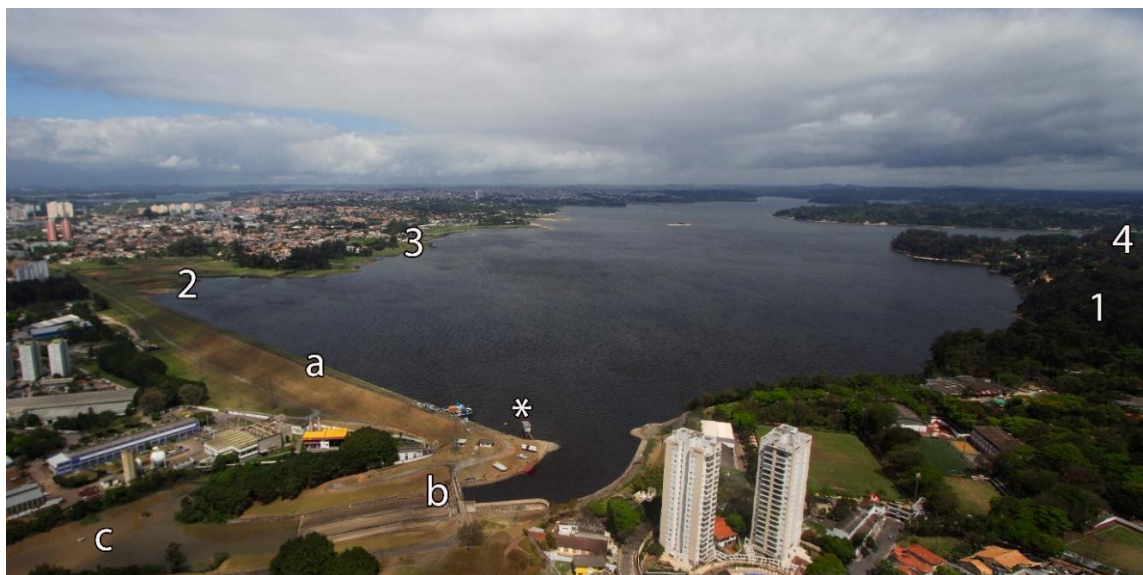
Figura 2. Imagem aérea da região da Barragem da represa do Guarapiranga. Localidades: 1. Parque Municipal Guarapiranga; 2. Parque Municipal Barragem de Guarapiranga; 3. Yacht Clube de Santo Amaro e Jardim Guarapiranga e 4. Jardim Tapera. As letras indicam: a. Barragem da represa; b. Comporta da represa e c. Canal/leito original do rio Guarapiranga. O asterisco indica o ponto de captação de água. Foto: Fabio Schunck (22 de setembro de 2014).
