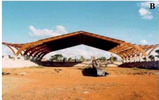
Figura 1. Vigas do Parque de Exposições de Brasília. A) Transporte; B) Montagem.
